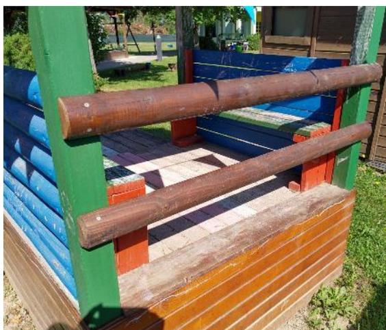
bei den Dachabschlusskanten unten gibt es Ecken in Kopfhöhe, diese sind abzurunden oder abzuschrägen
