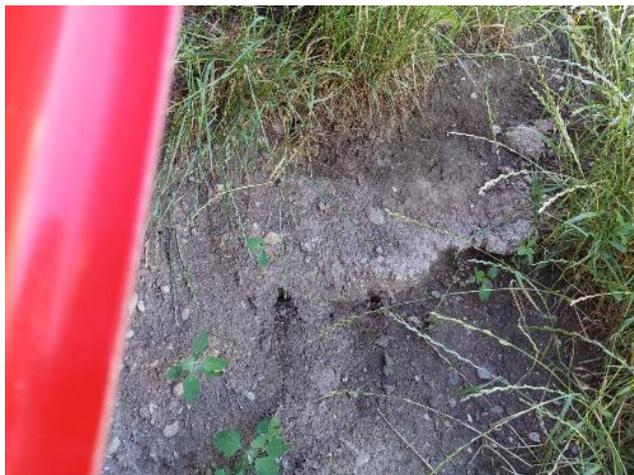
der Rutschauslauf ist zu hoch über dem Boden, max. 35 cm sind zulässig, Kies ergänzen, ggf. Gummimatten unterlegen zum stabilisieren des Niveaus
