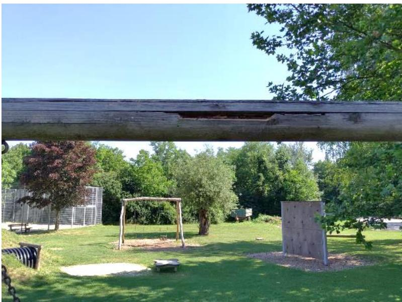
beim Boden wächst mind. 1 Wurzel in Richtung Aufprallfläche der Schaukel, die Wurzel abschneiden
