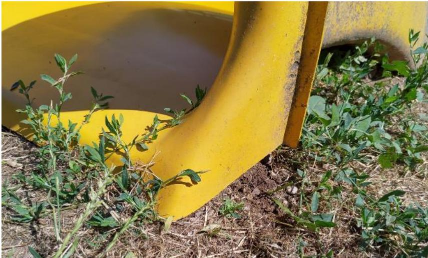
beim Reifenaufstieg zum Hügel ist der oberste Reifen eingerissen und zu ersetzen
